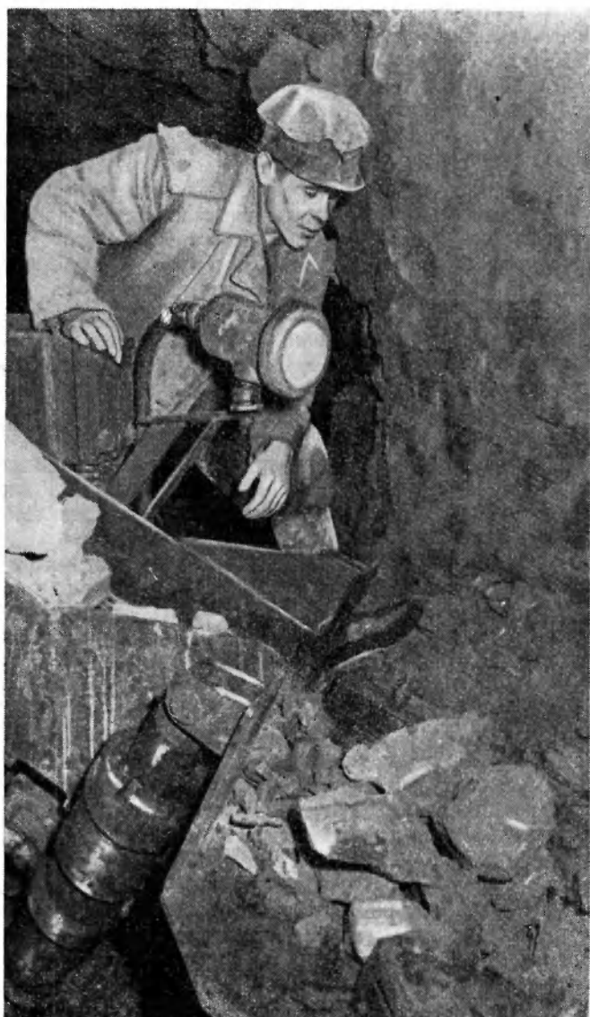
Добыча сланца. Работа погрузочной машины ГНЛ-30.
