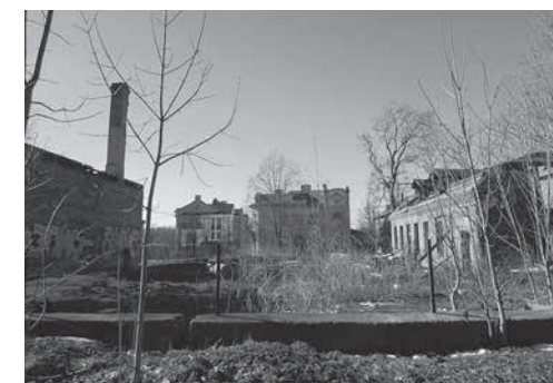
Участок бывшего дома № 51 на улице Чкалова в Гатчине. Снимок начала 2010-х гг. В центре — дома №№ 34, 36 на противоположной стороне улицы Чкалова.
