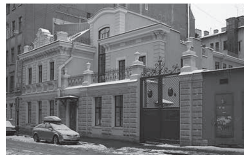
Дом Е.Е. Глухарева с торговыми помещениями и складами на 6-й Красноармейской улице, 10 в Петербурге. Построен в 1899 году по проекту архитектора Н.М. Самойлова
