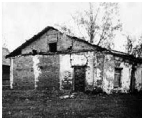
Северный корпус бывшей почтовой станции в д. Выра
