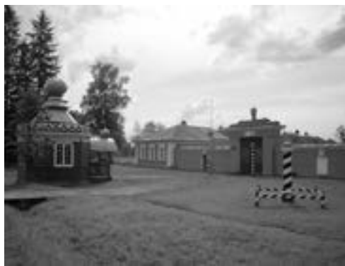
Музей «Дом станционного смотрителя» в деревне Выра
