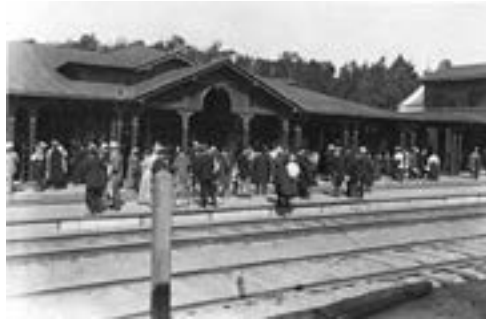
Станция Сиверская. В ожидании поезда. Фотография 1900-х годов
