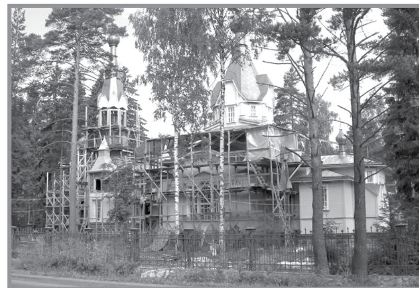
Строительные работы по реконструкции храма велись в 2007-2008 гг.
