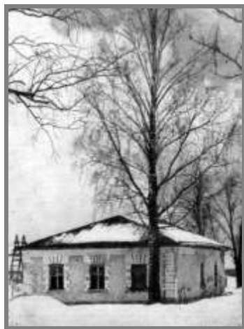
Выра. Здание почтовой станции. Фото 1950-х гг.
