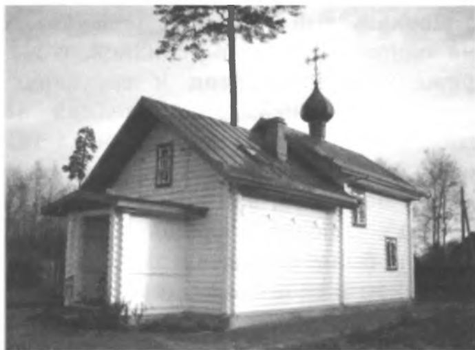
Храм Владимирской иконы Божией Матери в пос. Елизаветино. Построен в 2005 г.
