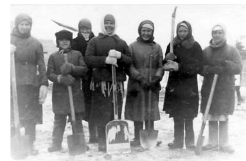
Местные жители на расчистке летного поля. Сиверская
