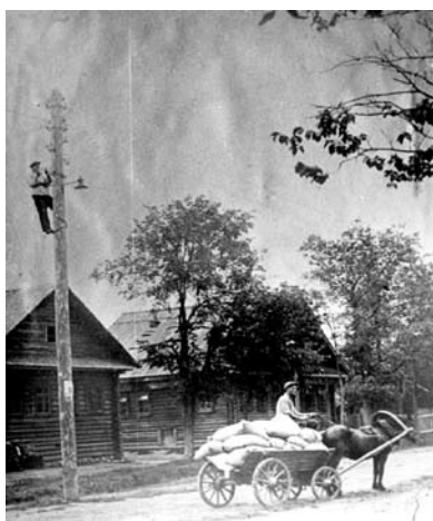
Установка электричества в Рождествено. 1936
