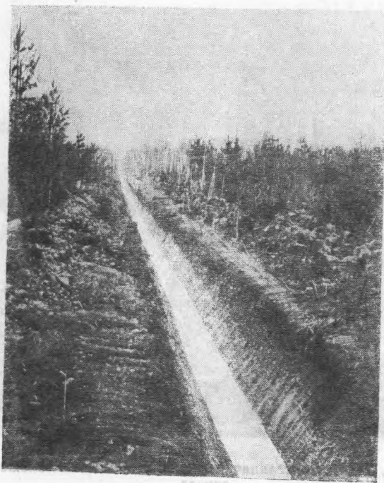
Рис. 75. Осушительная канава с трехчетвертным заложением откоса.
