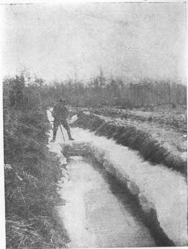
Рис. 79. Подготовка Окружной канавы к весеннему сплаву древесины. Очистка от льда.
