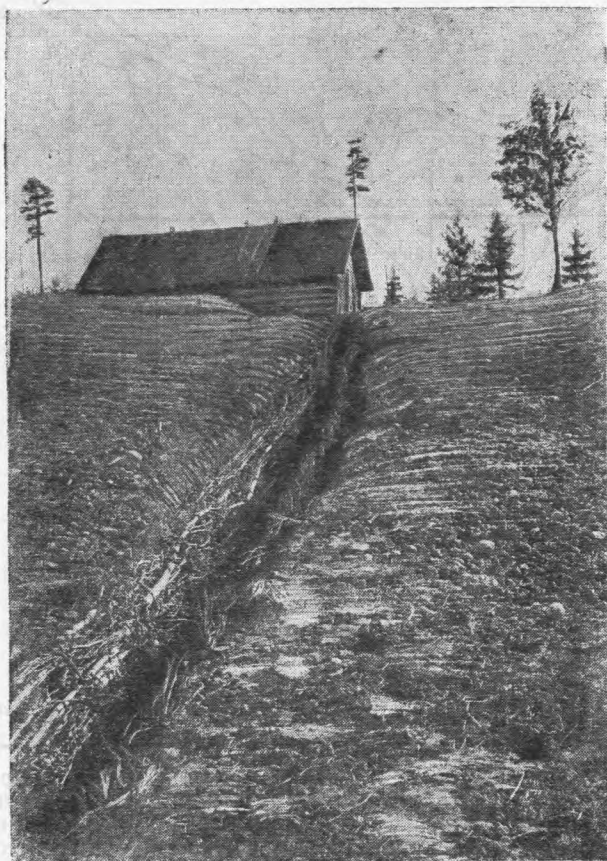
Рис. 103. Фашинный быстроток в 39 квартале Дружно-сельского отреза.
