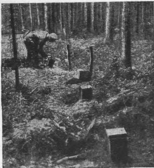
Рис. 89. Смотровые колодцы с деревянной отделкой для наблюдения над грунтовыми водами.
