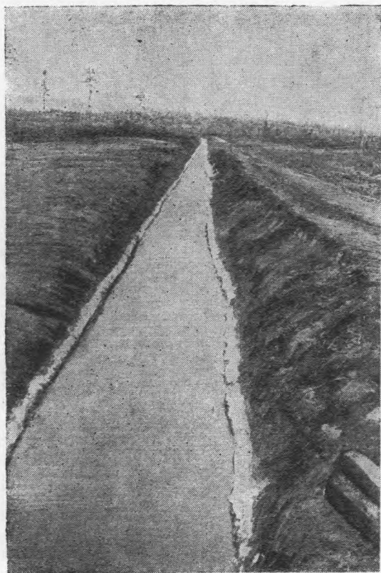
Рис. 80. Канавы, очищенная от льда и снега для проведения сплава древесины по ней.
